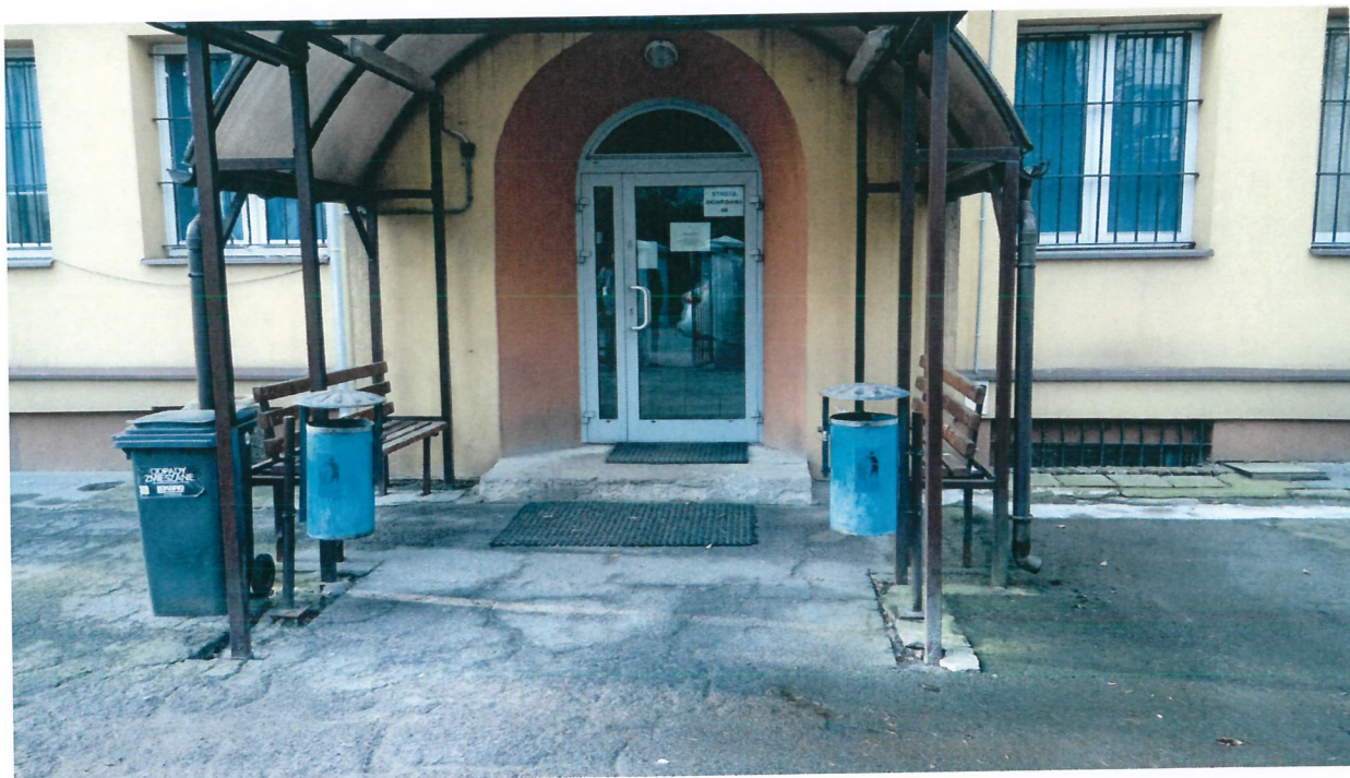
Wejście główne do budynku – widoczna część konstrukcji zadaszenia
