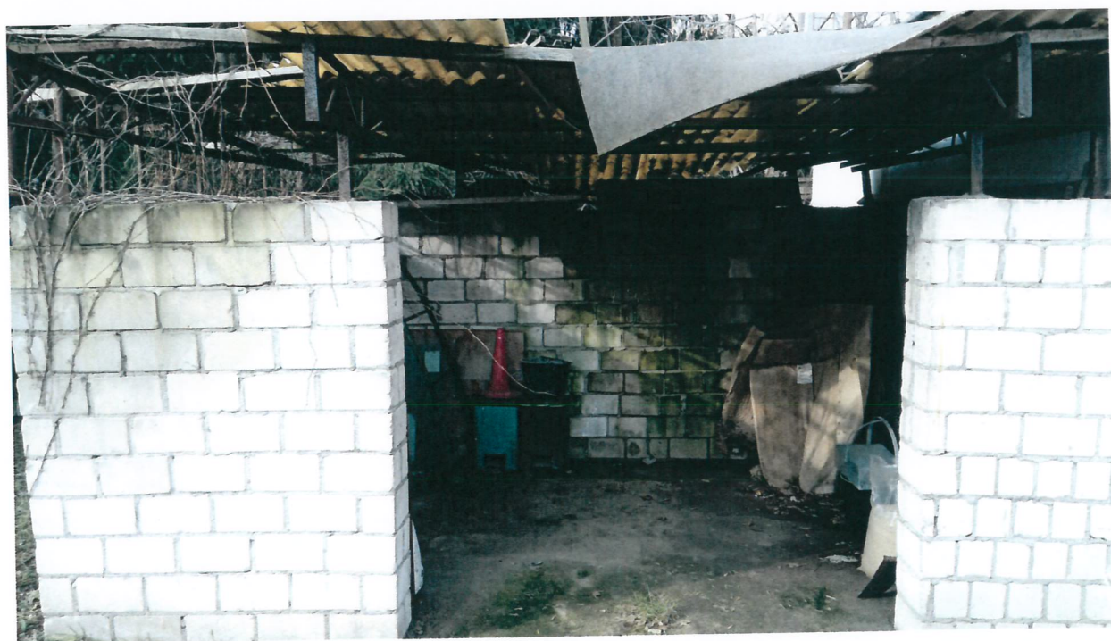
Boks garażowy – widoczne zniszczenia stropodachu i ścian
