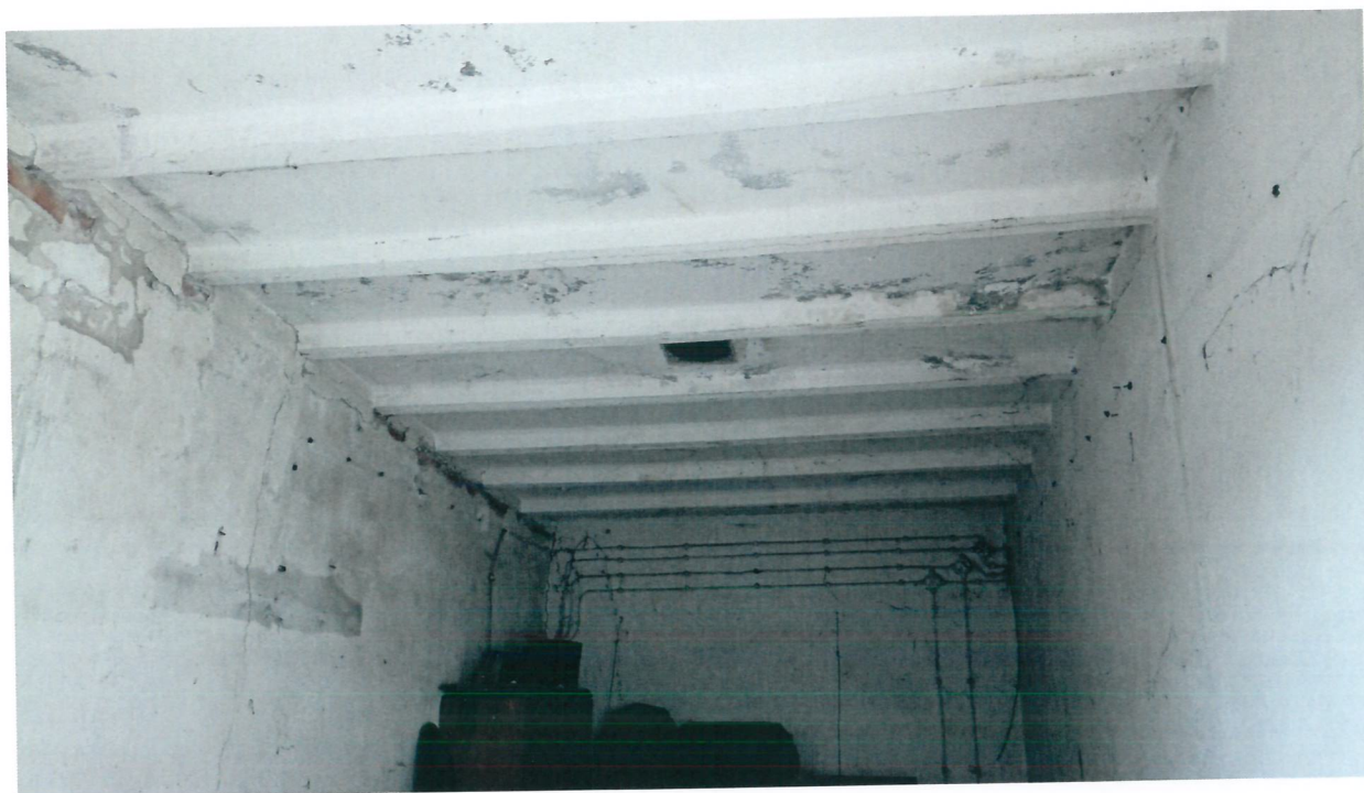
Boks garażowy – widoczne zniszczenia stropodachu i ścian
