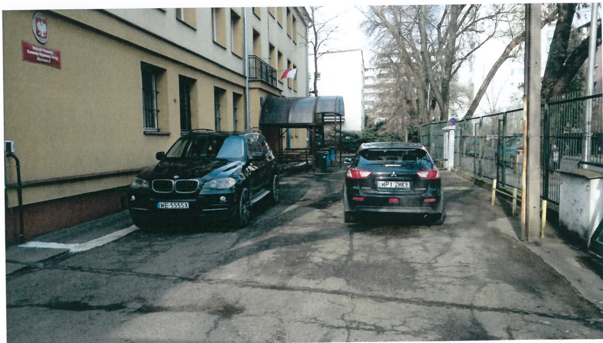
Teren utwardzony przed budynkiem – od strony ulicy
