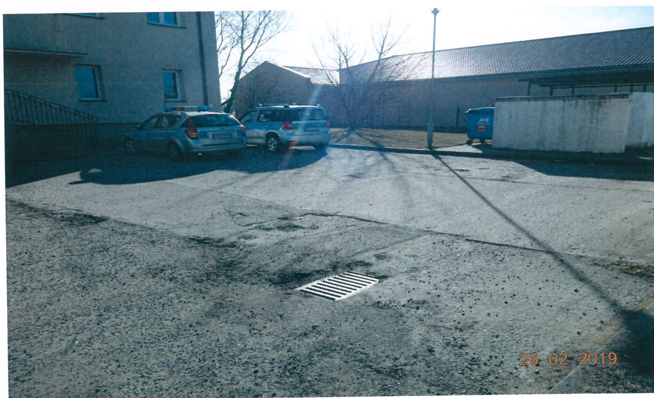
Obiekt nr 4 - Nawierzchnia drogowa - parking (plac manewrowy zatoki postojowe)
