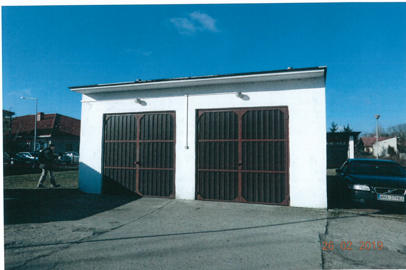
Obiekt nr 2 – Budynek garażu
