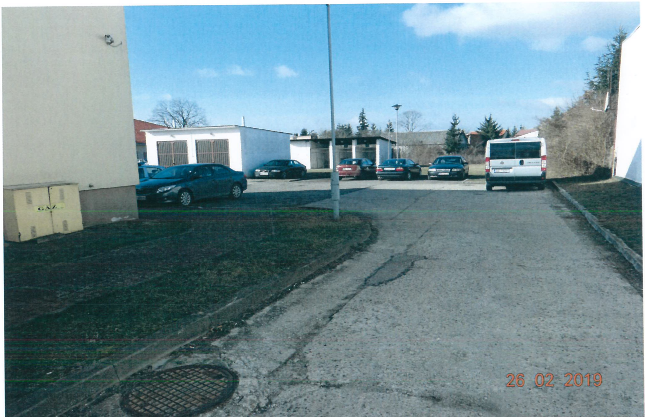
Obiekt nr 4 - Nawierzchnia drogowa - parking (droga wewnętrzna - wjazd na działkę); a
