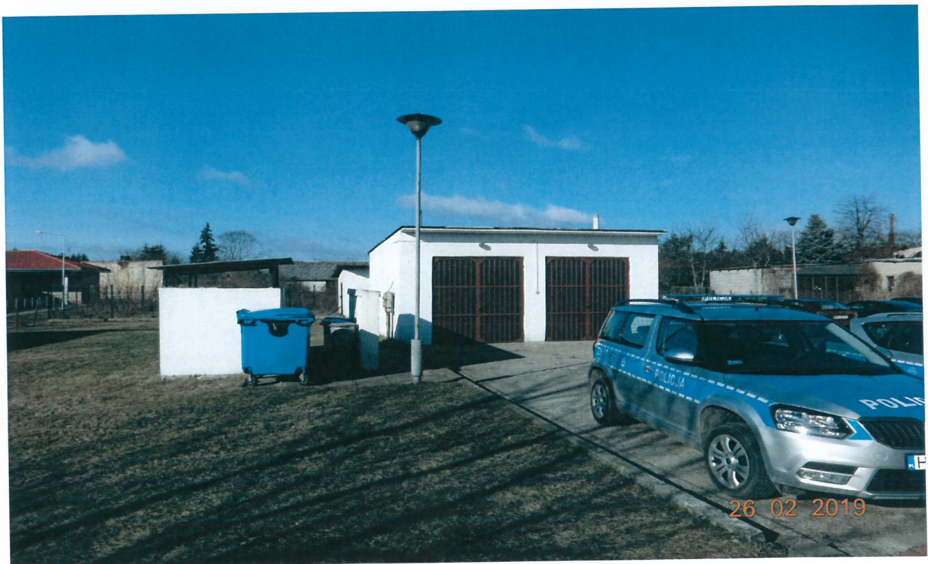
- Obiekt nr 3 – Wiata śmietnikowa, w głębi Obiekt nr 2 – Budynek garażu
