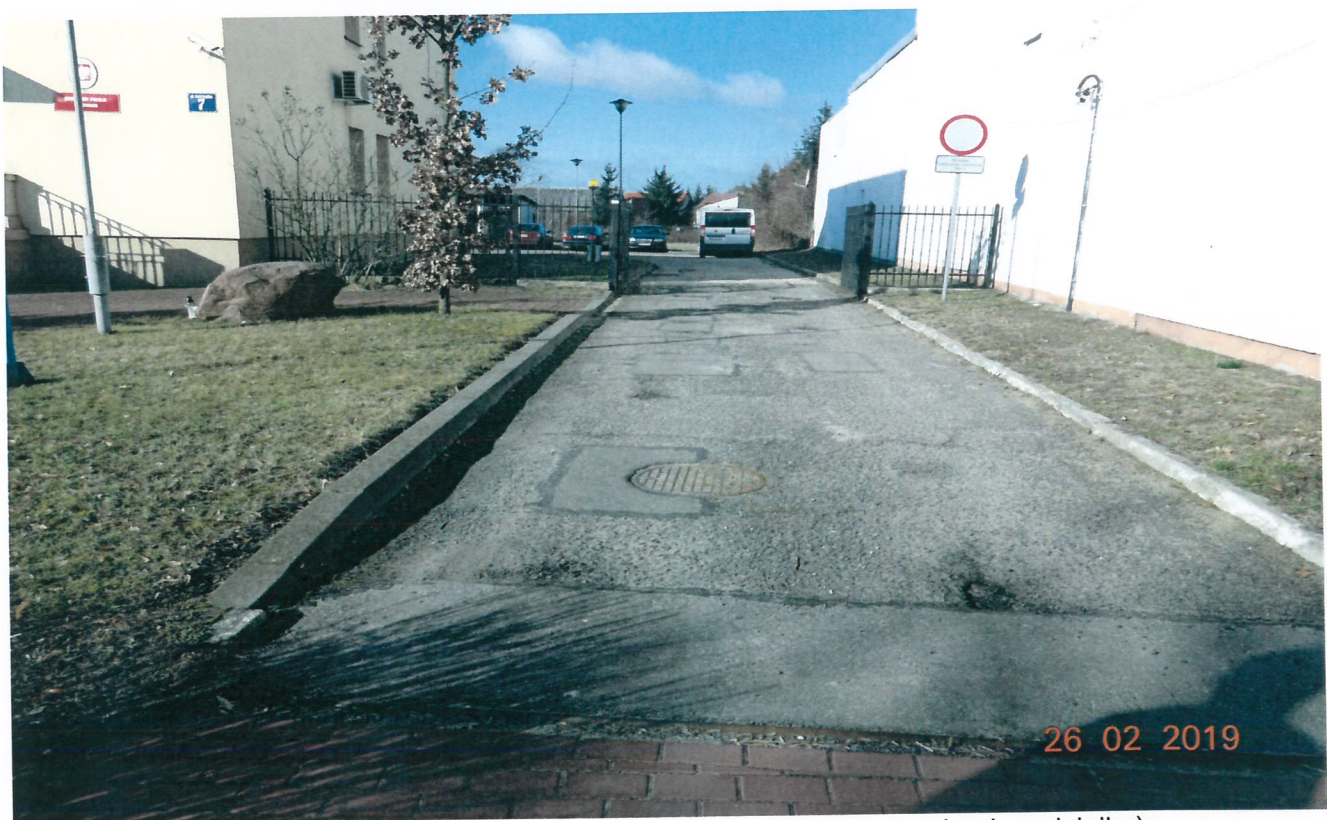
Obiekt nr 4 - Nawierzchnia drogowa - parking (droga wewnętrzna - wjazd na działkę);
