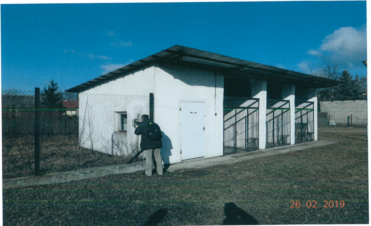
Obiekt nr 1 – Kojce –wiata dla psów służbowych, fragment ogrodzenia wybiegu (do wyburzenia)
