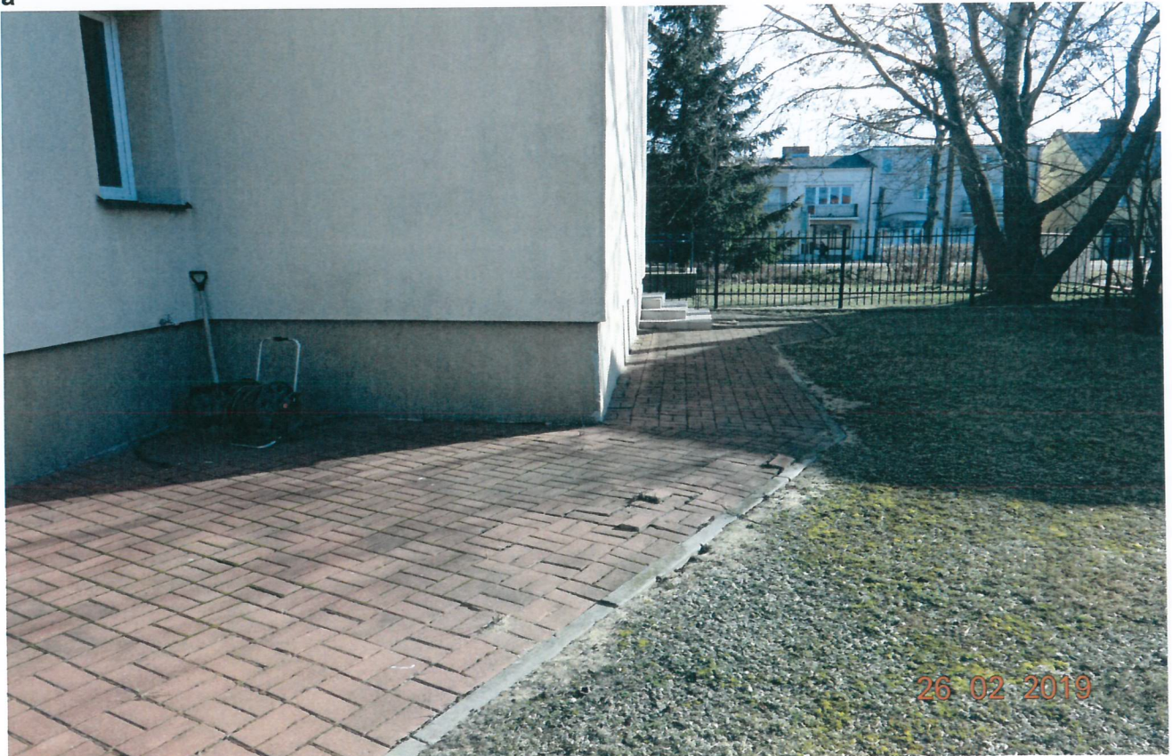
Obiekt nr 5- Chodnik z kostki betonowej (fragment do przełożenia – przy bud. KP)
