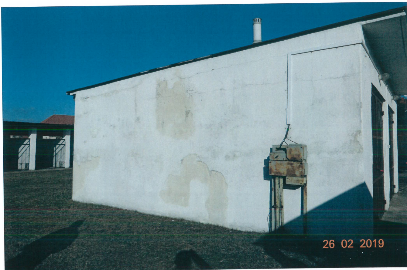
Obiekt nr 2 – Budynek garażu
