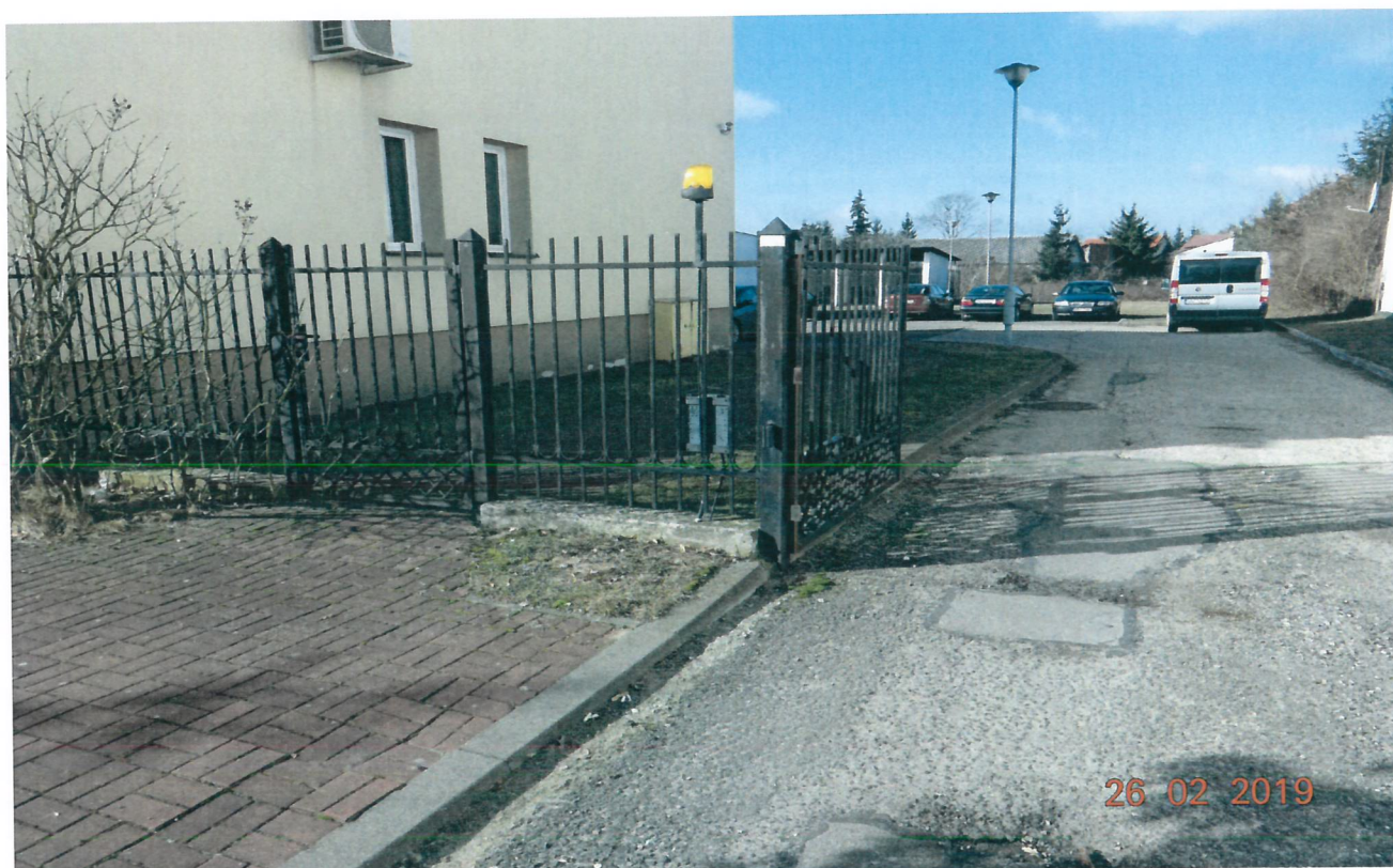
Obiekt nr 6 - Ogrodzenie od strony ul. Pułtuskiej - fragment z bramą wjazdową
