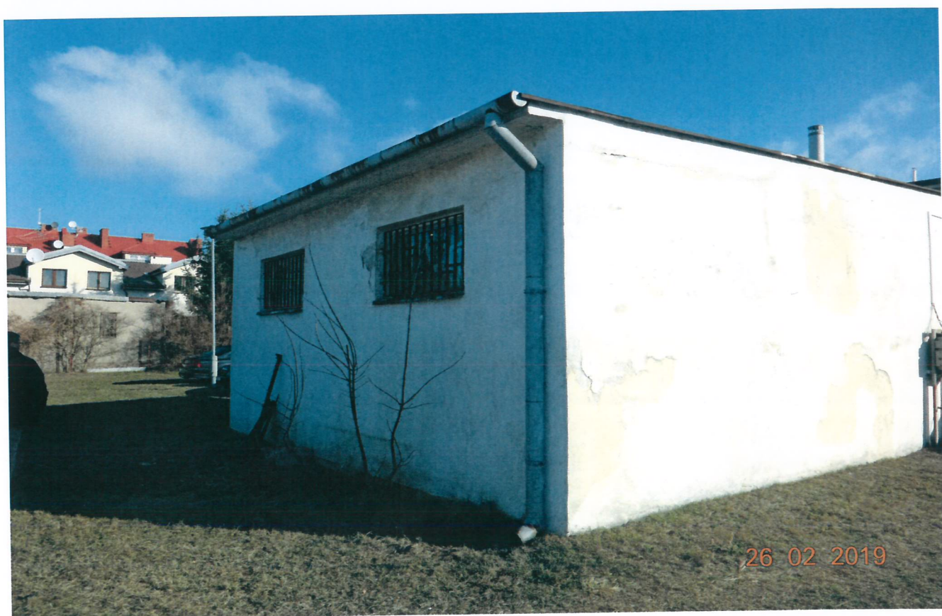
Obiekt nr 2 – Budynek garażu
