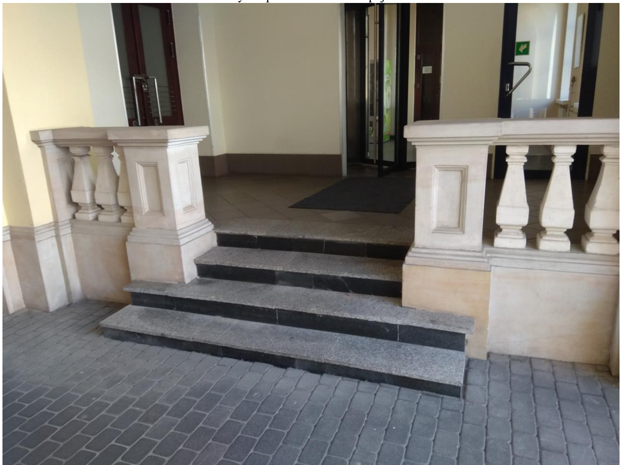
rys. 7 schody zewnętrzne prowadzące do zachodniego skrzydła Pałacu
