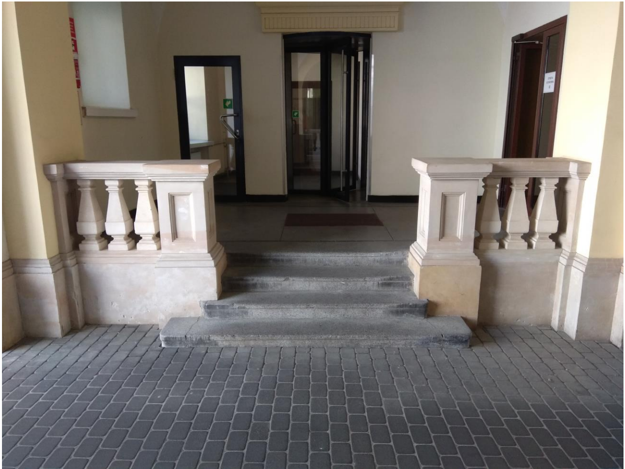
rys. 8 schody prowadzące do wschodniego skrzydła Pałacu
