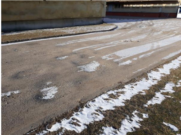
3. Stan drogi betonowej na dzień 05.03.2018 r.
