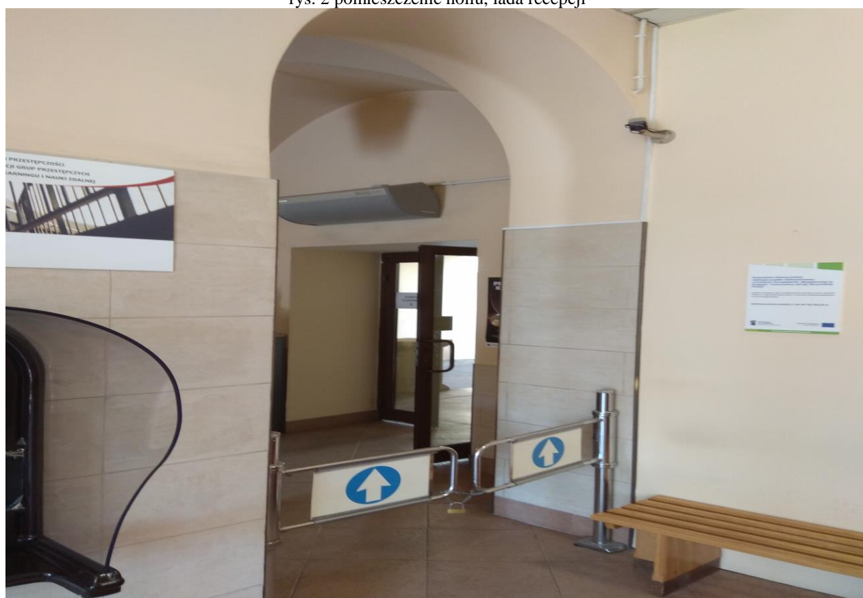
rys. 3 pomieszczenie hollu, bariarka przejściowa do demontaż
