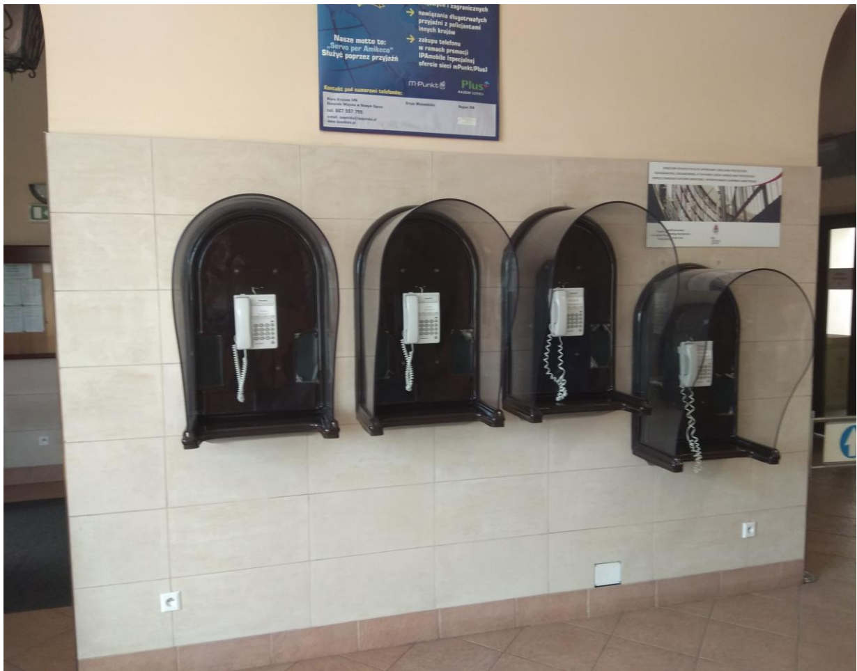
rys. 4 pomieszczenie hollu, budki telefoniczne
