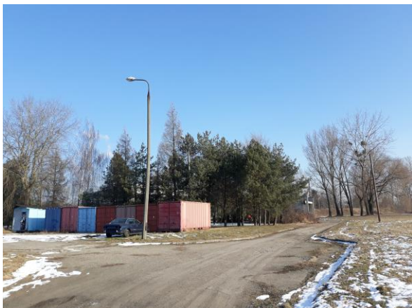
6. Stan drogi betonowej za wjazdem na plac manewrowy przed magazynami 05.03.2018 r.
