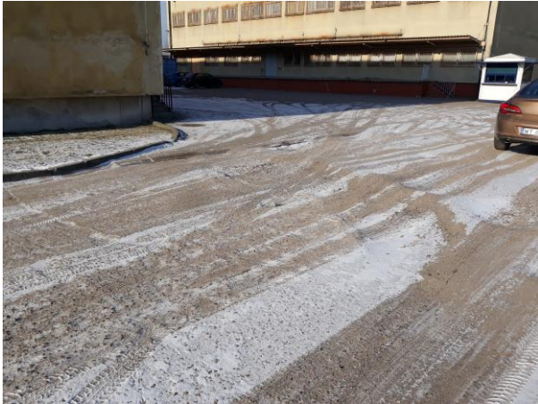
4. Styk drogi betonowej z placem manewrowym przed magazynami stan na 05.03.2018 r.
