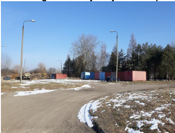
5. Stan drogi betonowej za wjazdem na plac manewrowy przed magazynami 05.03.2018 r.
