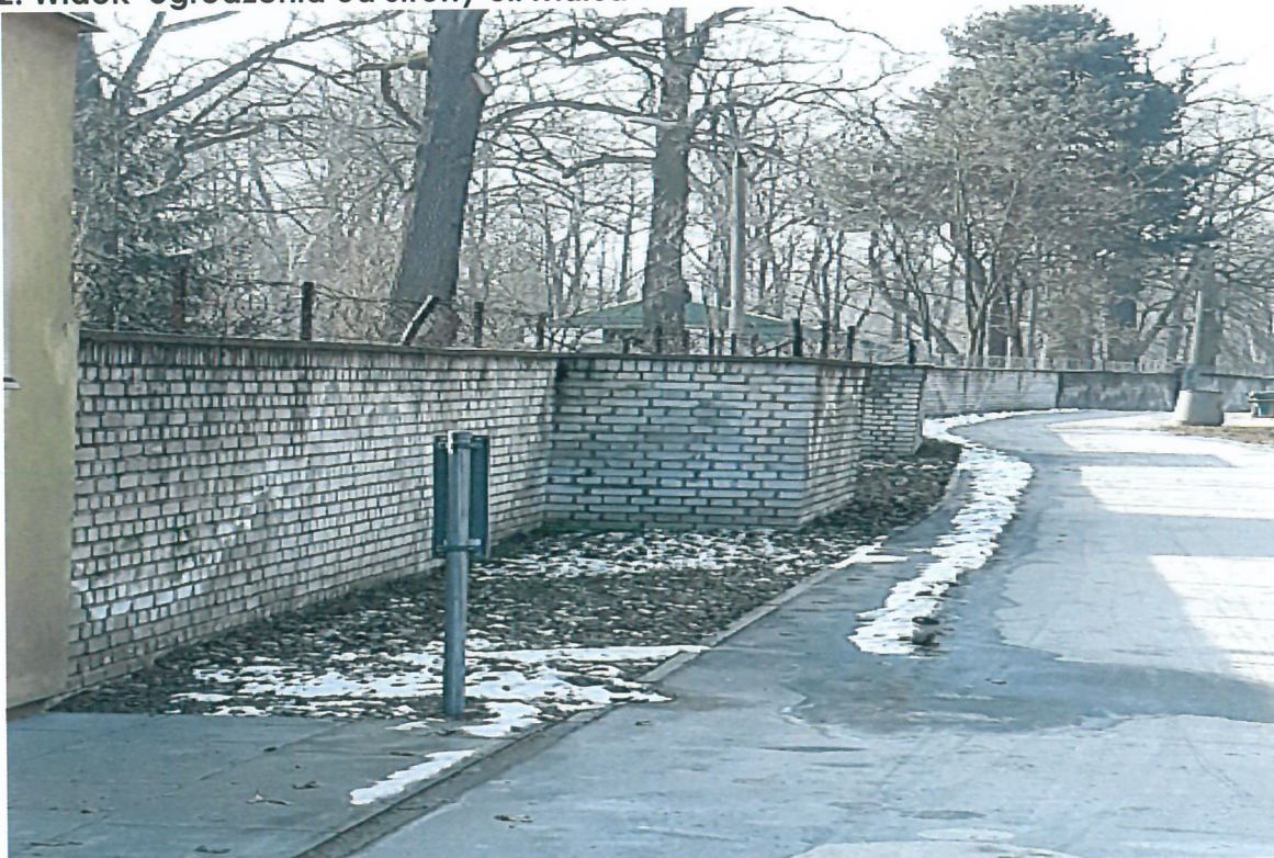
2. Widok ogrodzenia od strony ul. Marsa
