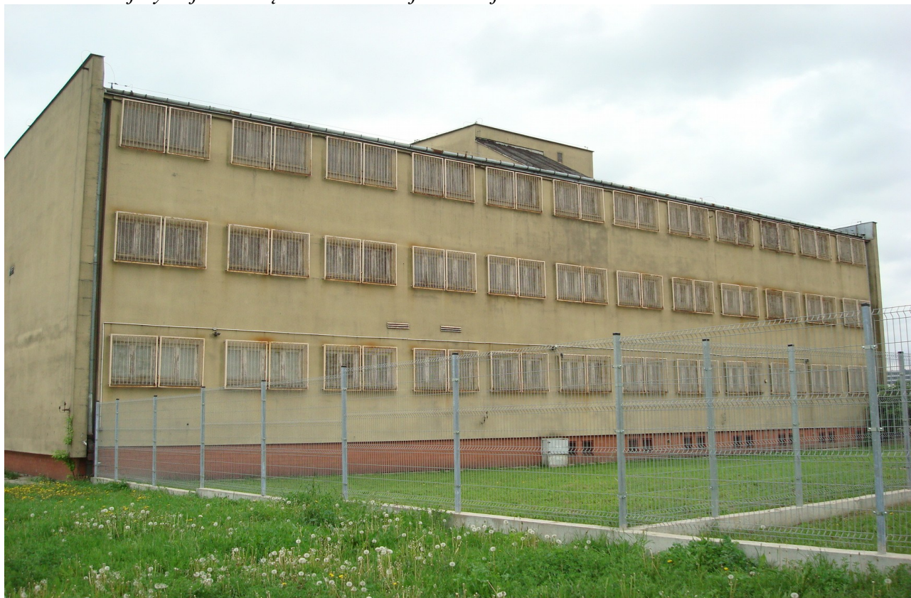
Widok elewacji tylnej oraz częściowo elewacji bocznej
