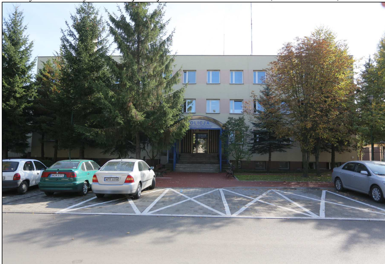
3. Budynek Komendy Powiatowej Policji w Grodzisku Mazowieckim, ul. Bartniaka 19;
