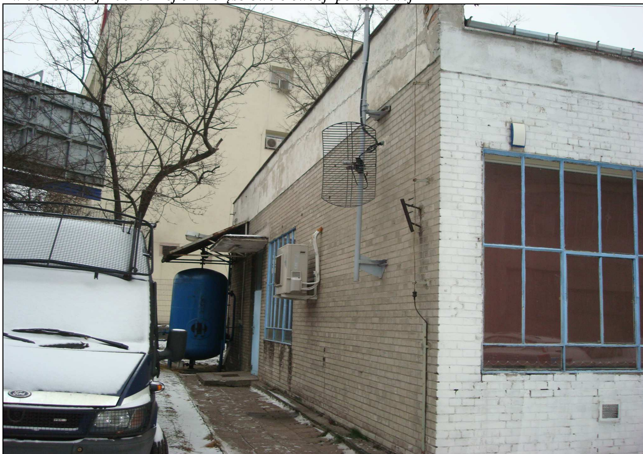
- widok elewacji zachodniej oraz częściowo elewacji południowej
