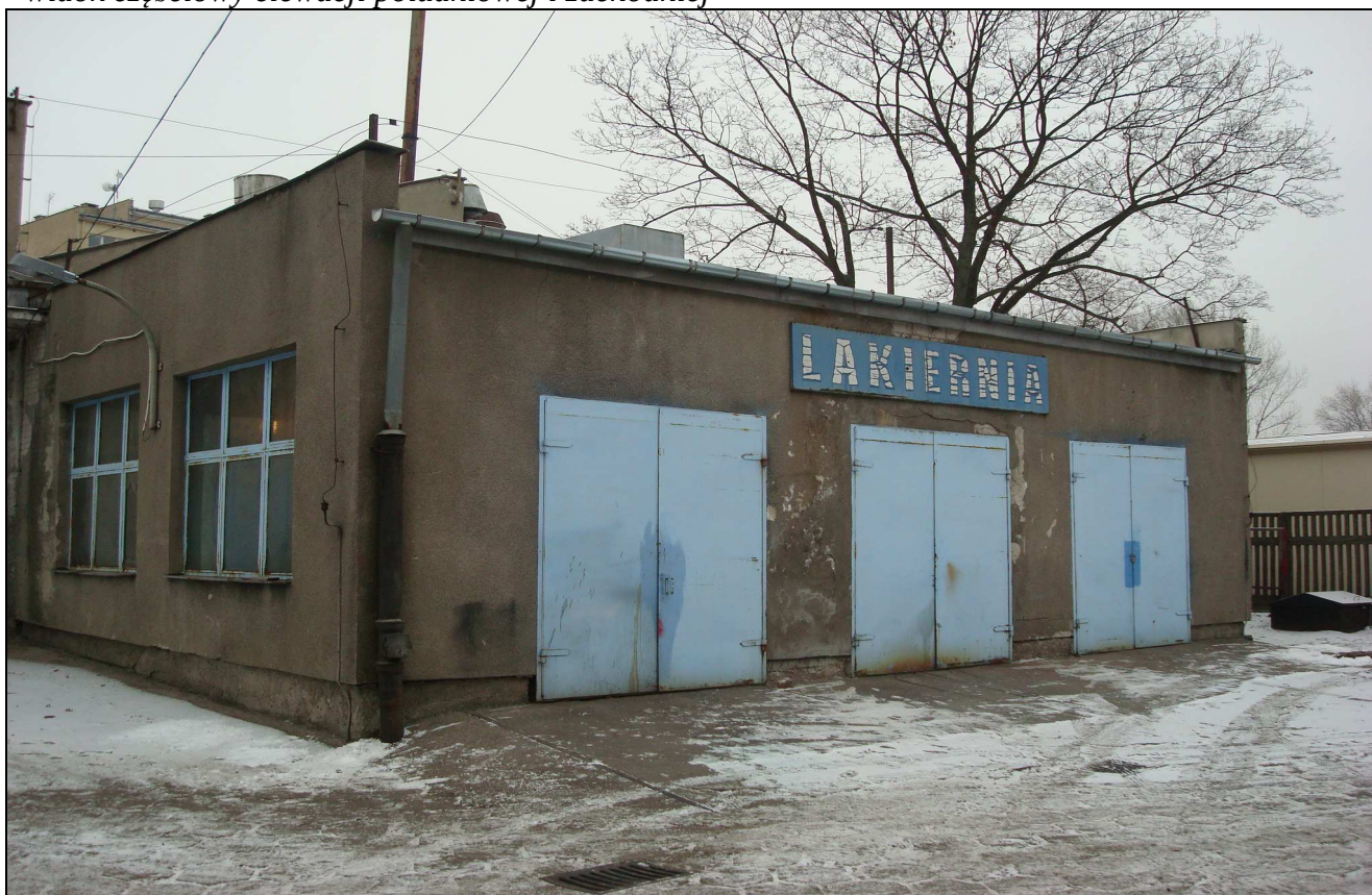
- widok częściowy elewacji południowej i zachodniej
