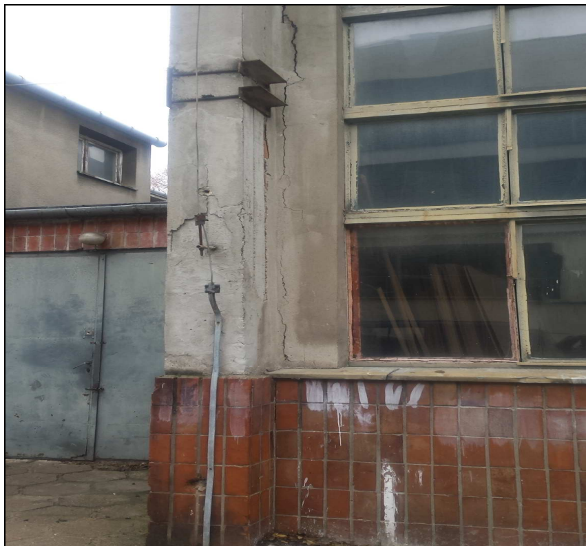
- widok pęknięcia w pomieszczeniu rozdzielni
