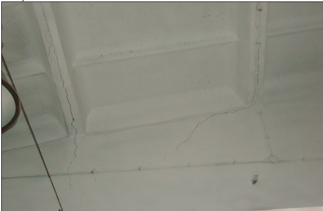
- widok od strony wewnętrznej pęknięć i zarysowań na ścianie zewnętrznej oraz stropodachu hali – elewacja wschodnia
