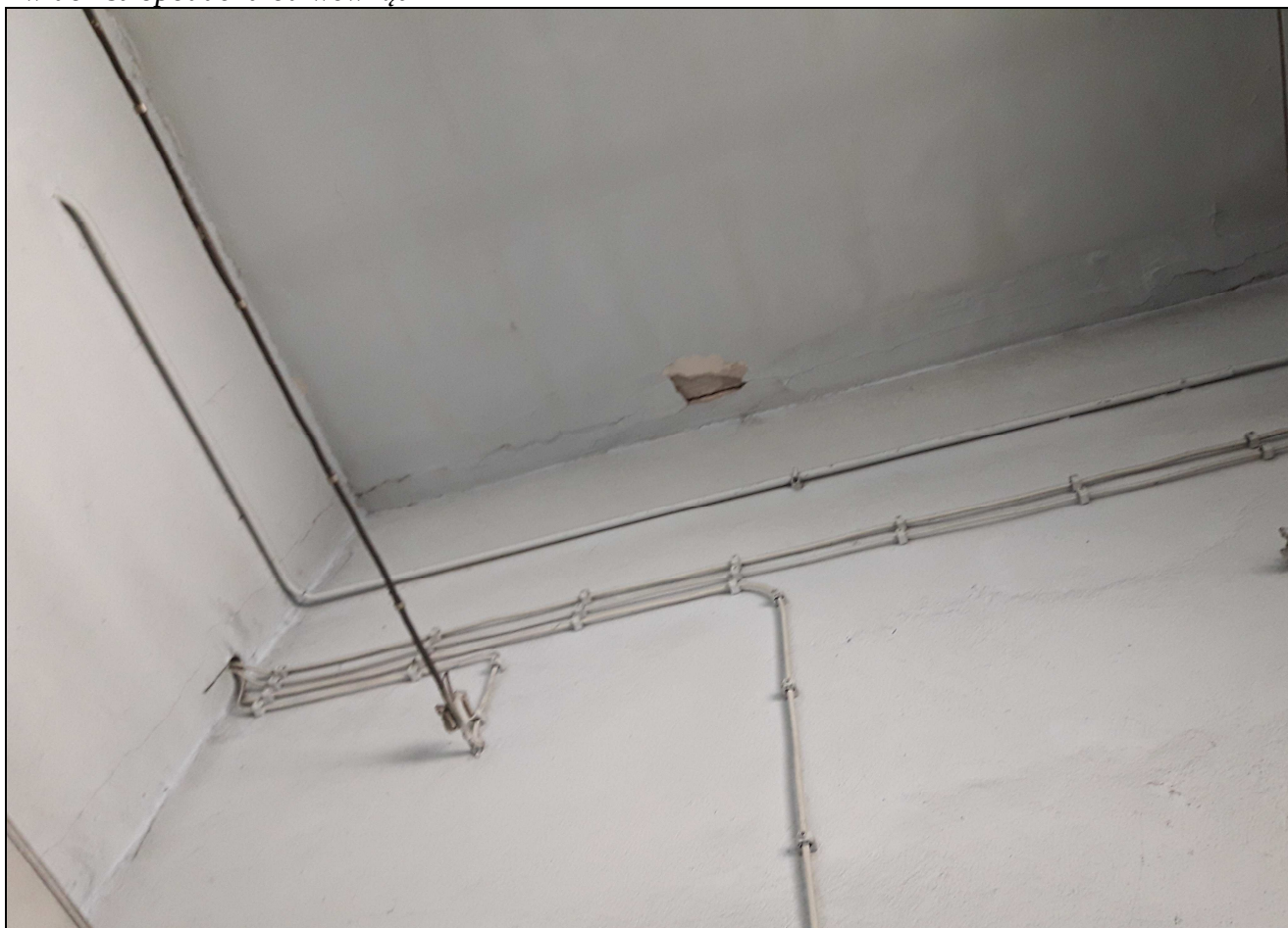
- widok stropodachu od wewnątrz
