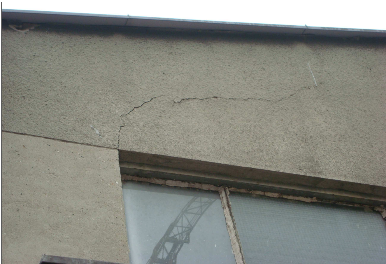
- widok od strony wewnętrznej pęknięć i zarysowań na ścianie zewnętrznej oraz stropodachu hali – elewacja wschodnia
