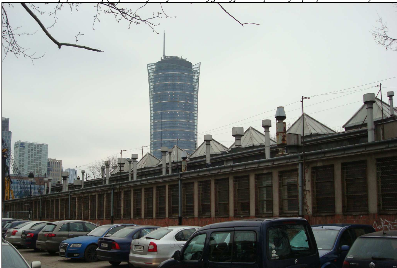
- widok elewacji północnej (część budynku jednokondygnacyjna z częściowym podpiwniczeniem)
