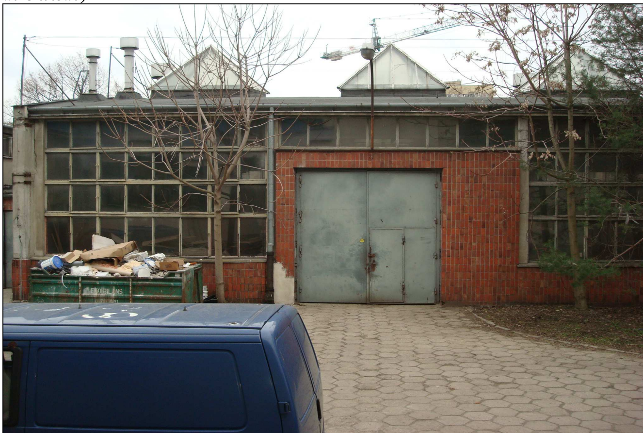
- widok częściowy elewacji południowej budynku (część budynku jednokondygnacyjna – hala warsztatowa)
