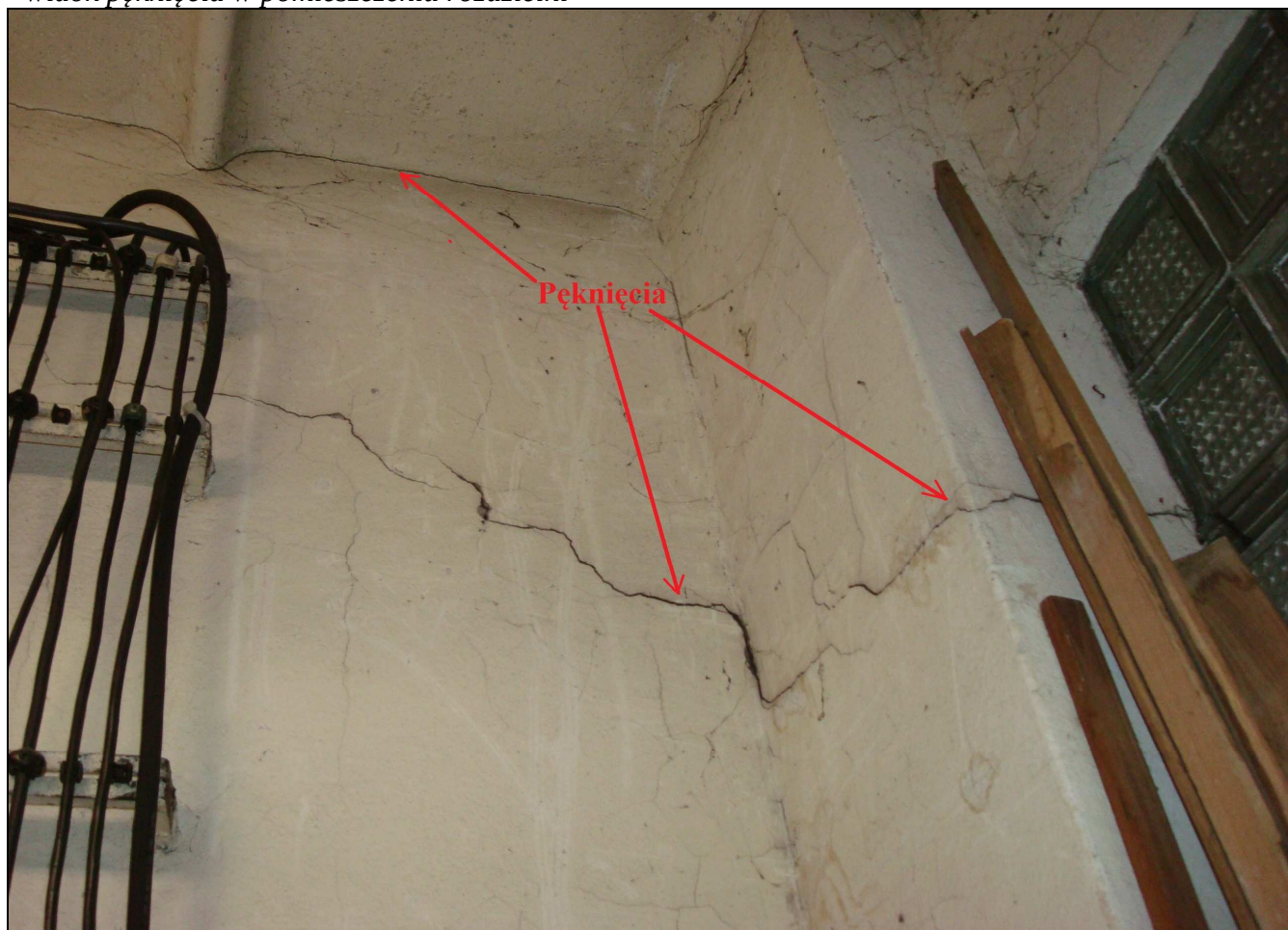
- widok pęknięcia w pomieszczeniu rozdzielni
