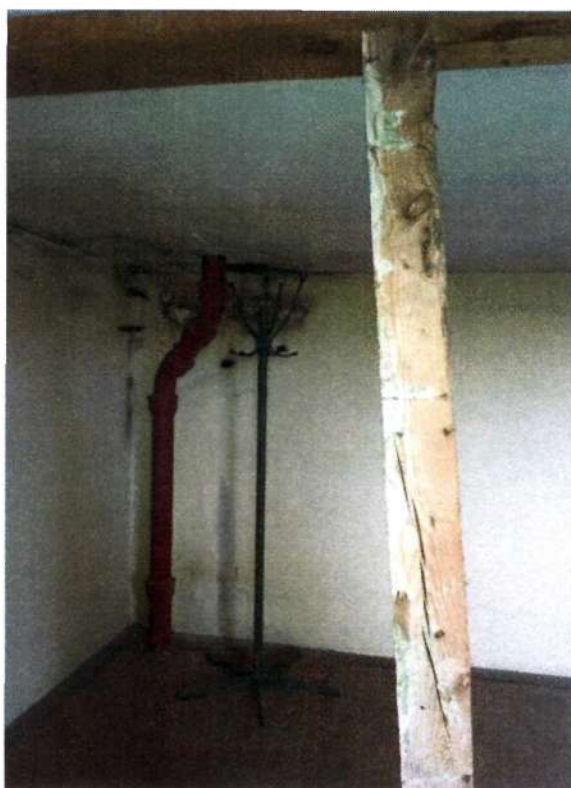
fot. nr 4 poddasze budynku
