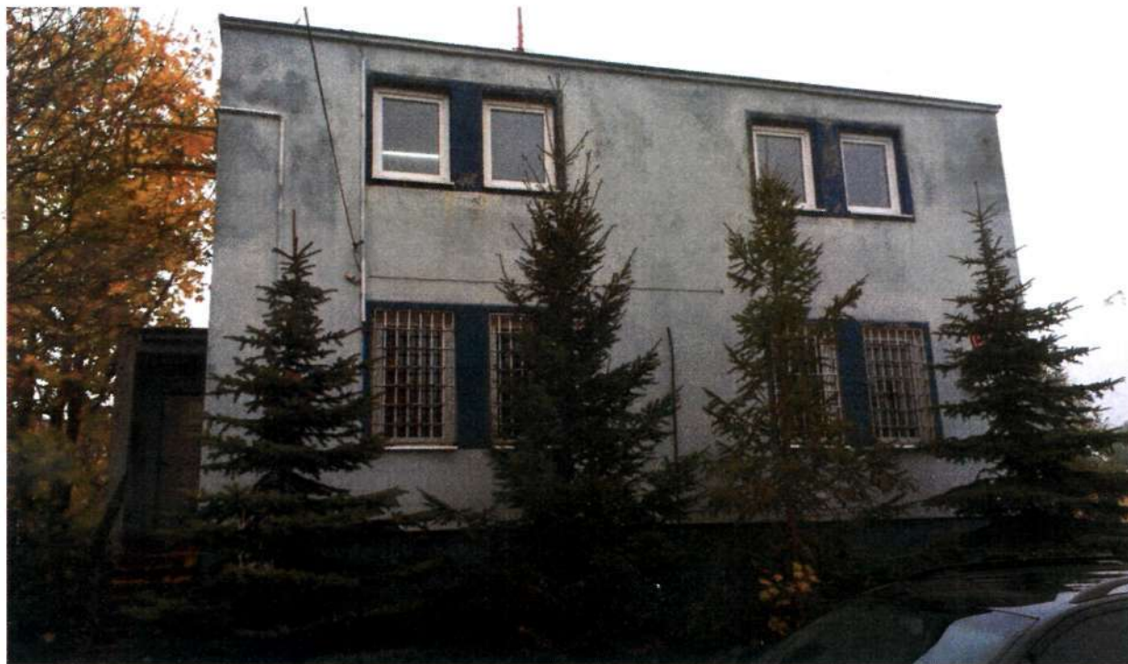
fot. nr 1 elewacja frontowa
