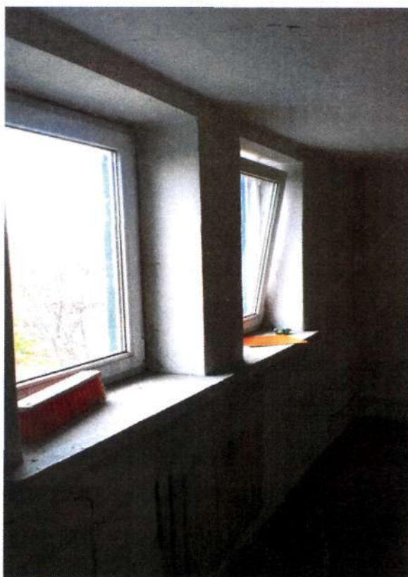
fot. nr 3 poddasze budynku
