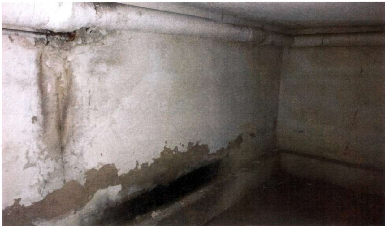
fot. nr 6 pomieszczenie piwnic
