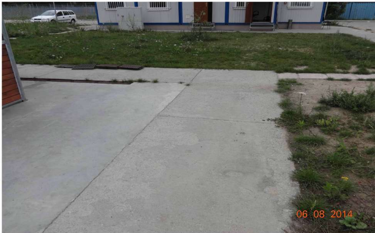
fot. 7 - Teren do rekultywacji, przy kontenerze /nr 5 wg szkicu /
