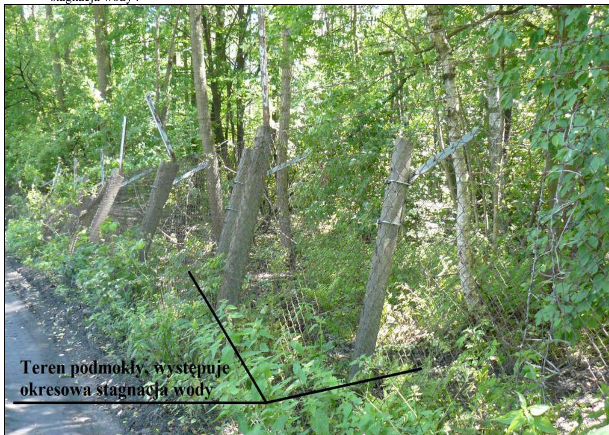
Fot. 3. Widok ogrodzenia podlegającego wymianie. Częściowo ogrodzenie zlokalizowane jest na terenie podmokłym. Po stronie wewnętrznej ogrodzenia widoczny teren podmokły – okresowo występuje stagnacja wody .
