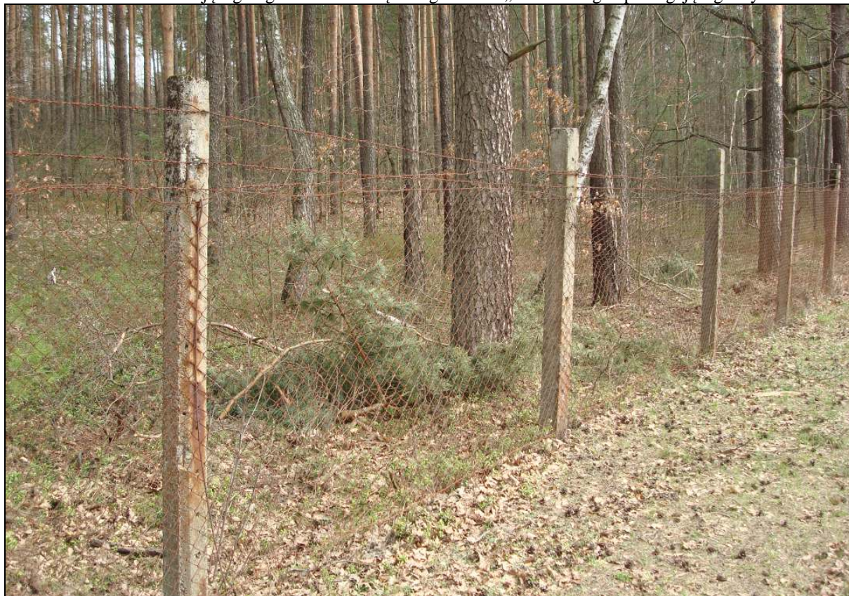
Fot.8. Widok ogrodzenia podlegającego wymianie, po stronie wewnętrznej ogrodzenia teren leśny po stronie zewnętrznej ogrodzenia biegnie droga wewnętrzna asfaltowa.
