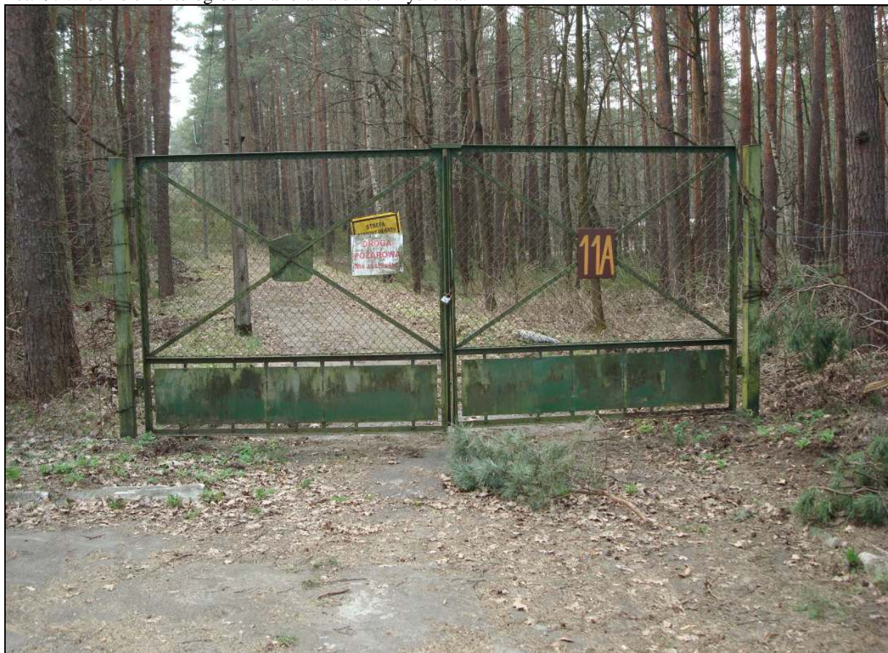
Fot.19. Widok elementu ogrodzenia -brama dwuskrzydłowa.
