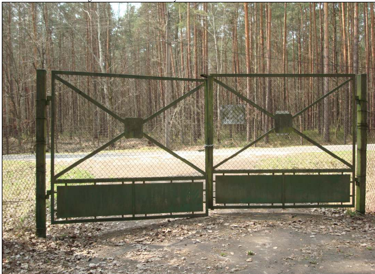
Fot. 20. Widok elementu ogrodzenia -brama dwuskrzydłowa.
