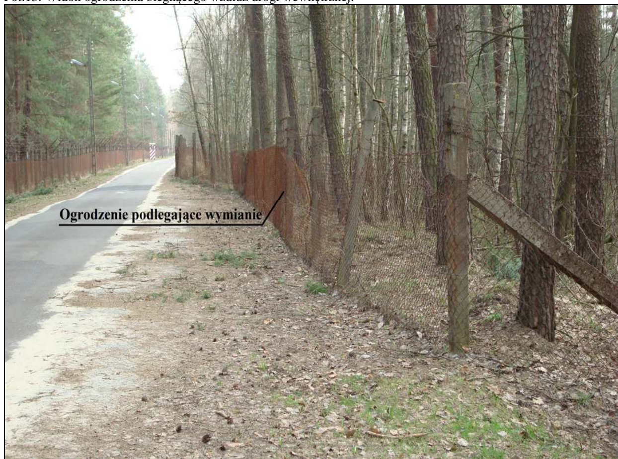
Fot.13. Widok ogrodzenia biegnącego wzdłuż drogi wewnętrznej.
