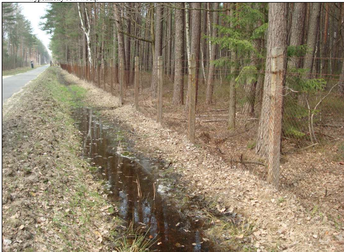
Fot.10. Widok ogrodzenia biegnącego wzdłuż rowu odwadniającego i drogi wewnętrznej. Widoczny częściowo wypełniony rów wodą.
