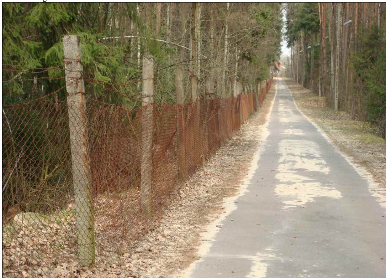
Fot.12. Widok ogrodzenia biegnącego wzdłuż drogi wewnętrznej. Ogrodzenie usytuowanej jest na skraju skarpy drogi.
