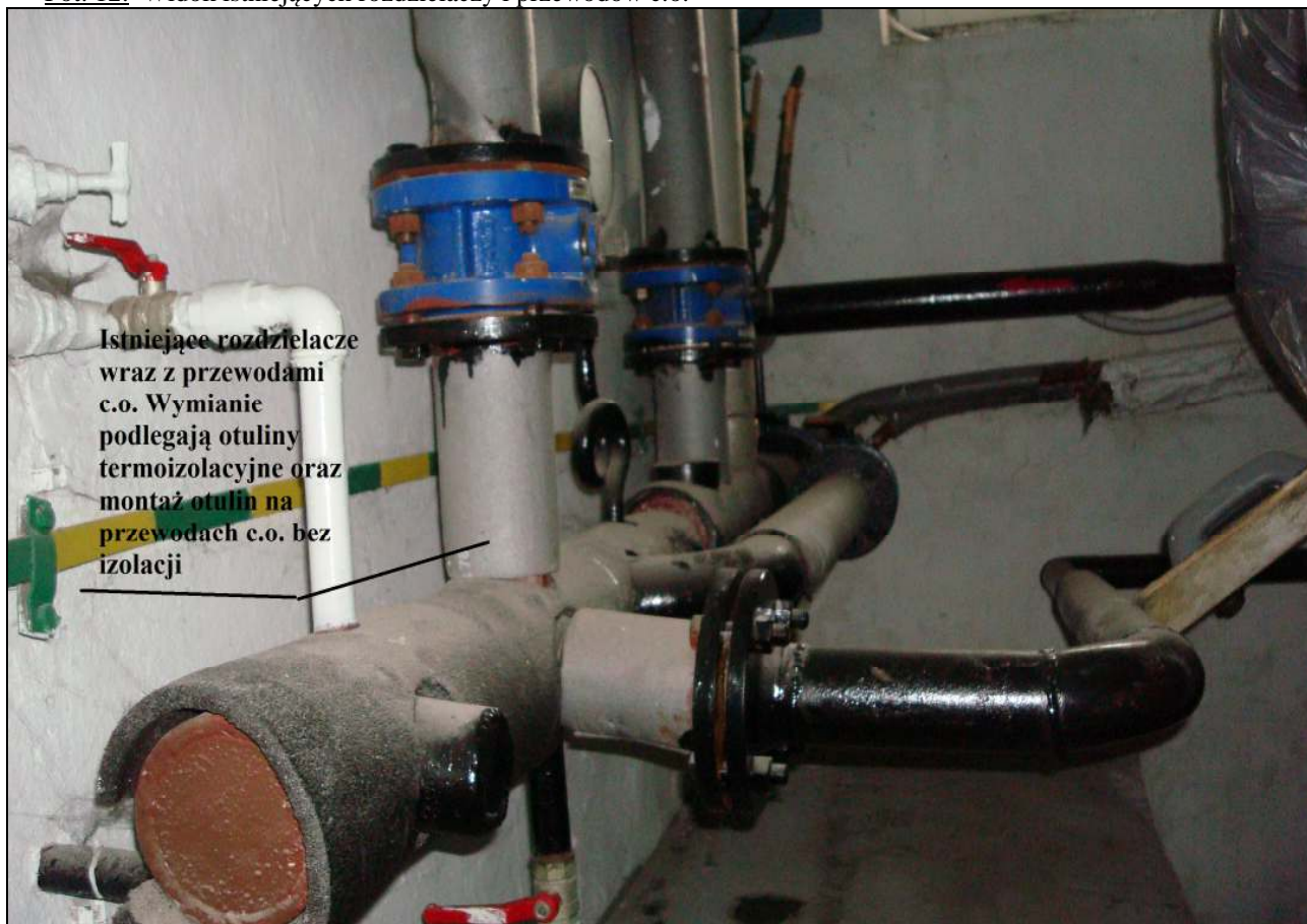
Fot. 12. Widok istniejących rozdzielaczy i przewodów c.o.
