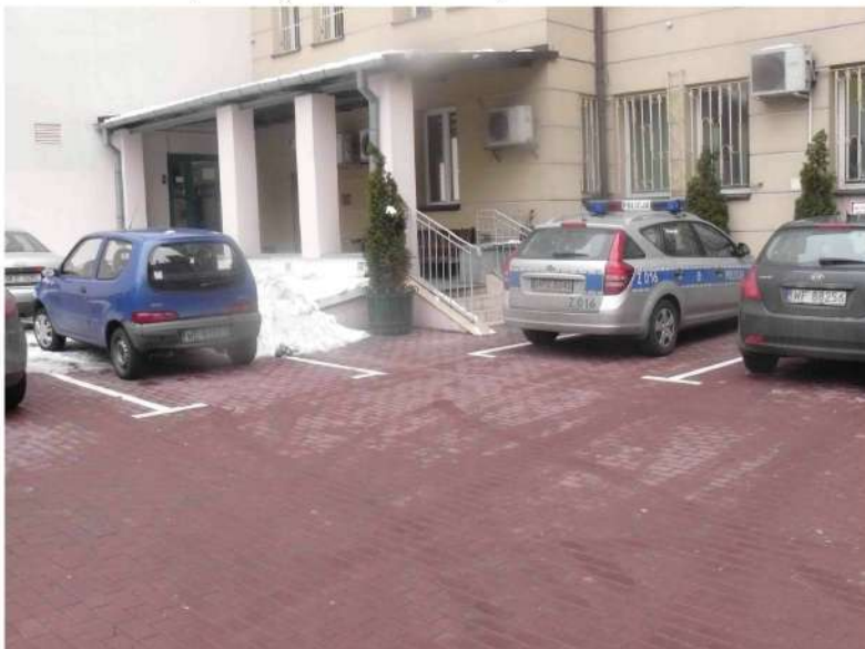
Fot. 2-4 Widok elewacji budynku KRP od podwórza
