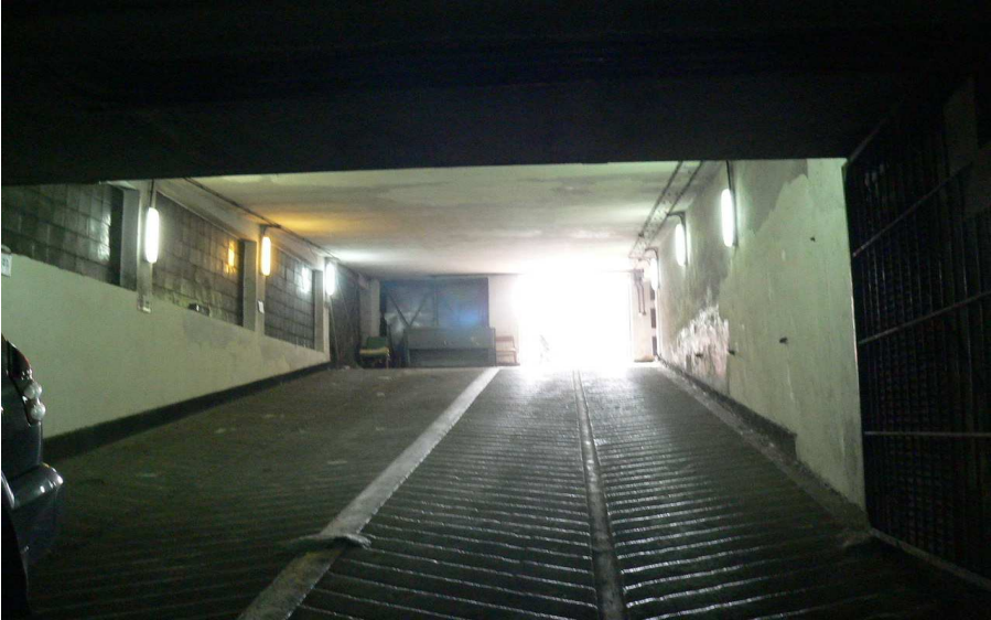
Fot. 3, 4 i 5 Widok zjazdu do garażu podziemnego od ul. Kłopotowskiego;
