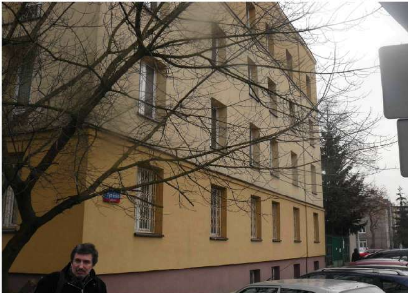
Fot. 2 Widok elewacji bocznej budynku KRP II od ul. Tynieckiej
