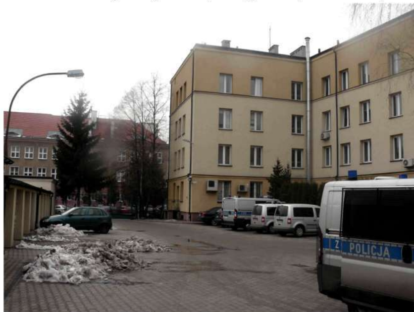
Fot. 8 Widok dziedzińca wewnętrznego i budynku garażu (strona lewa)
