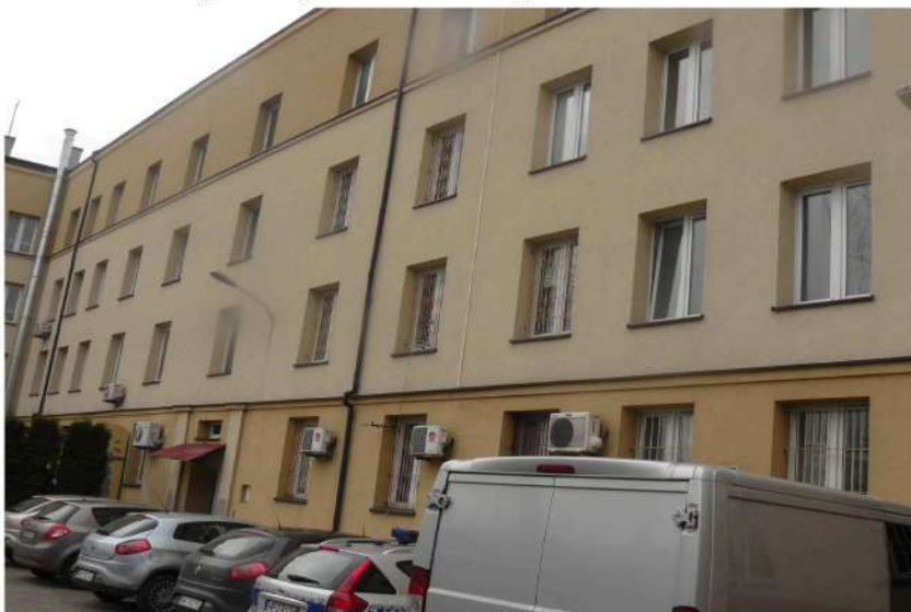
Fot. 3 i 4 Widok elewacji budynku KRP od podwórza
