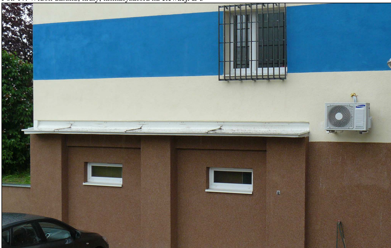
Fot. 17. Widok daszku, kraty, klimatyzatora na elewacji E-3
