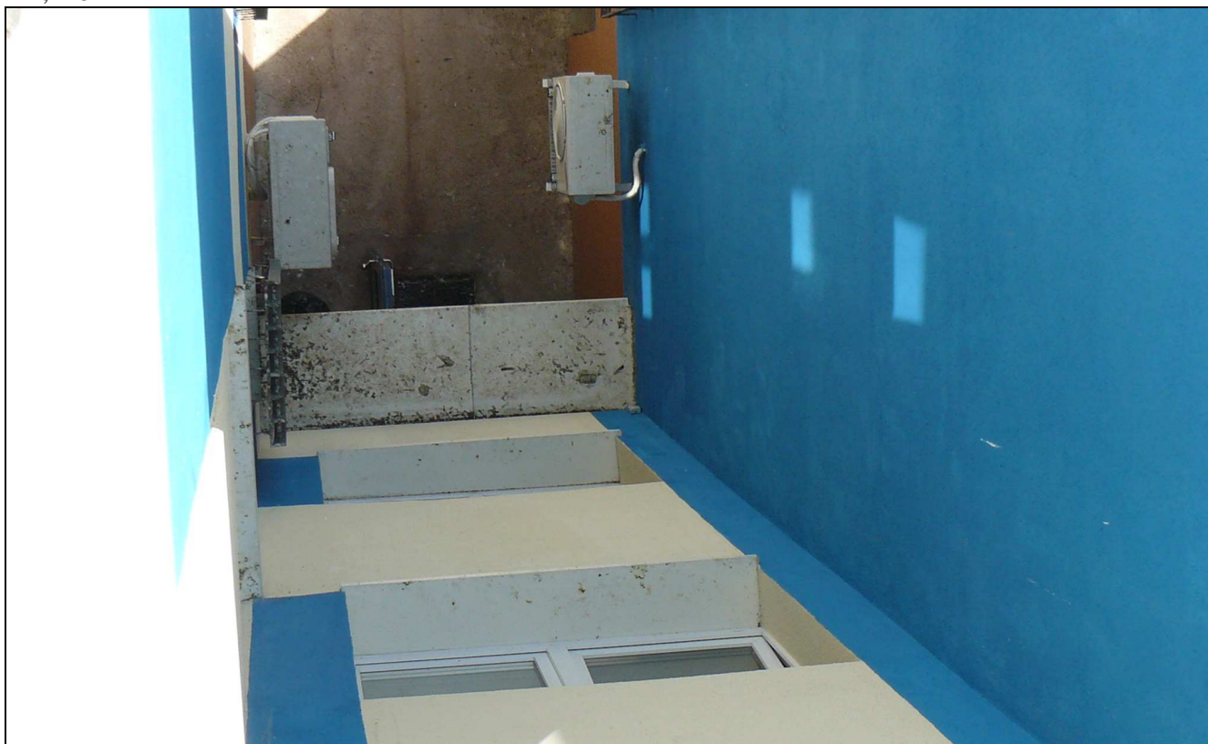
Fot. 21. Widok z góry daszku, parapetów zewnętrznych na elewacji E-3. Widok klimatyzatorów z góry na elewacji E-4, E-5
