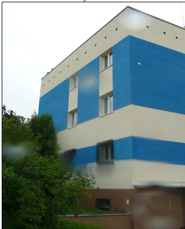
Fot. 5. Widok elewacji E-7
