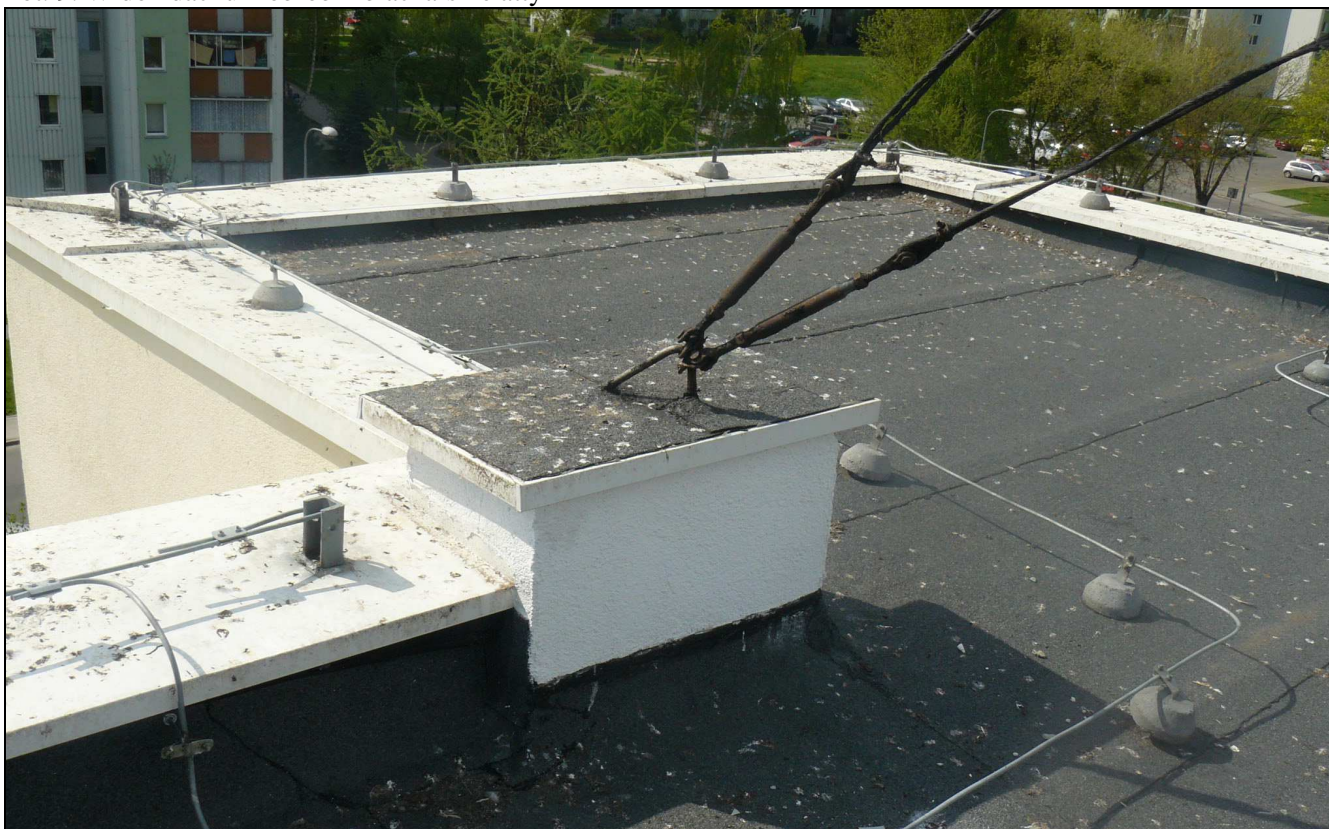
Fot. 9. Widok dachu – obróbki blacharskie attyk
