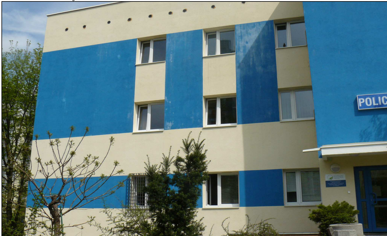
Fot. 1. Widok elewacji E-1
