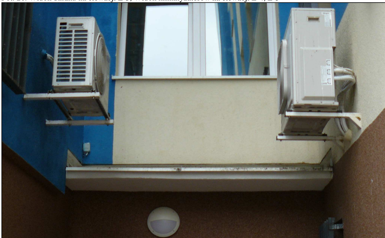
Fot. 20. Widok daszku na elewacji E-3, Widok klimatyzatorów na elewacji E-4, E-5
