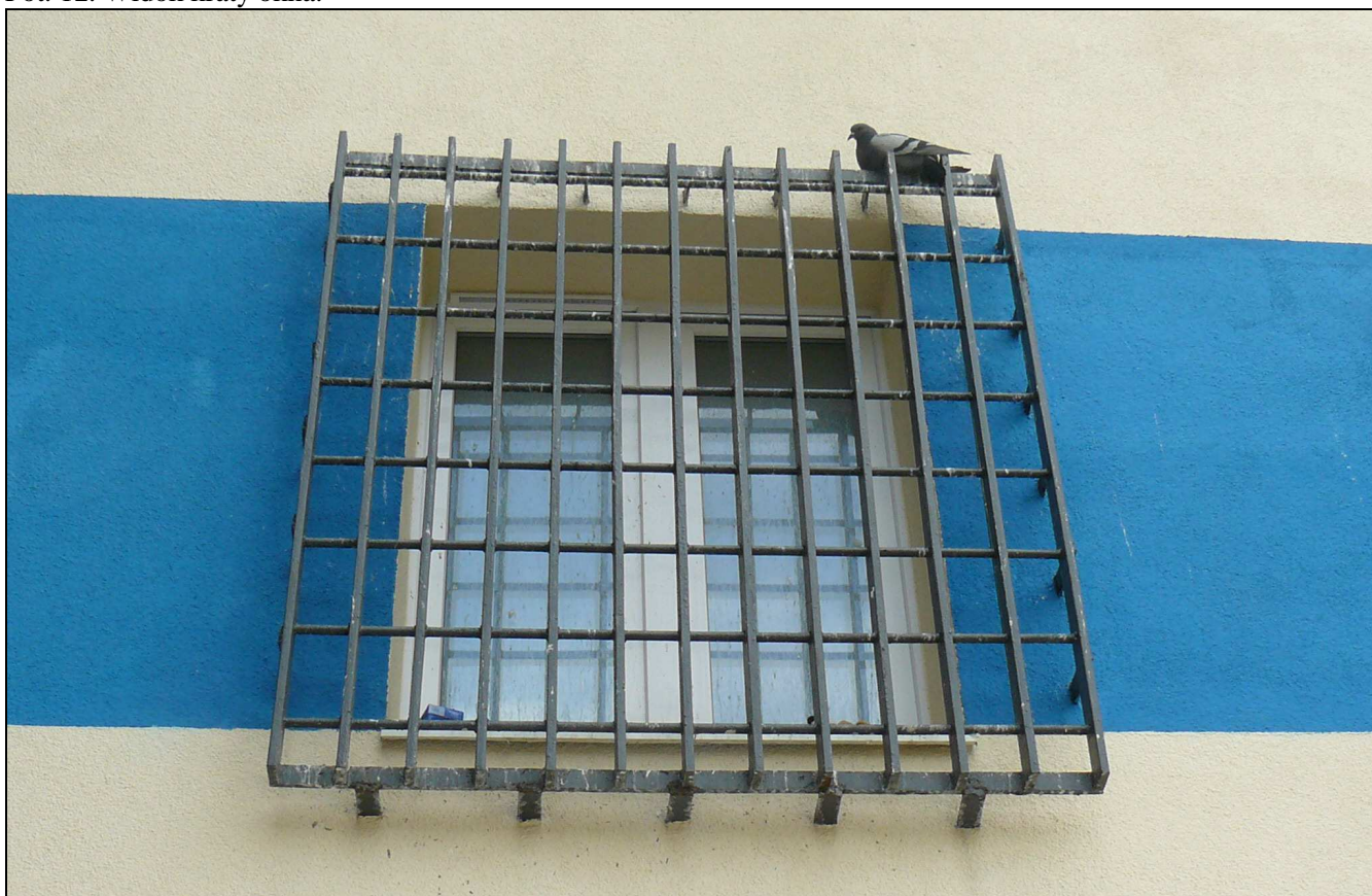
Fot. 12. Widok kraty okna.
