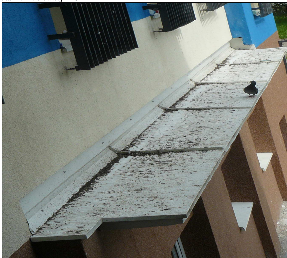
Fot. 16. Widok daszku na elewacji E-5
