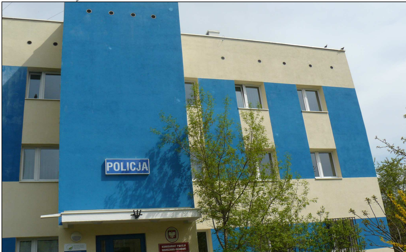
Fot. 2. Widok elewacji E-1
