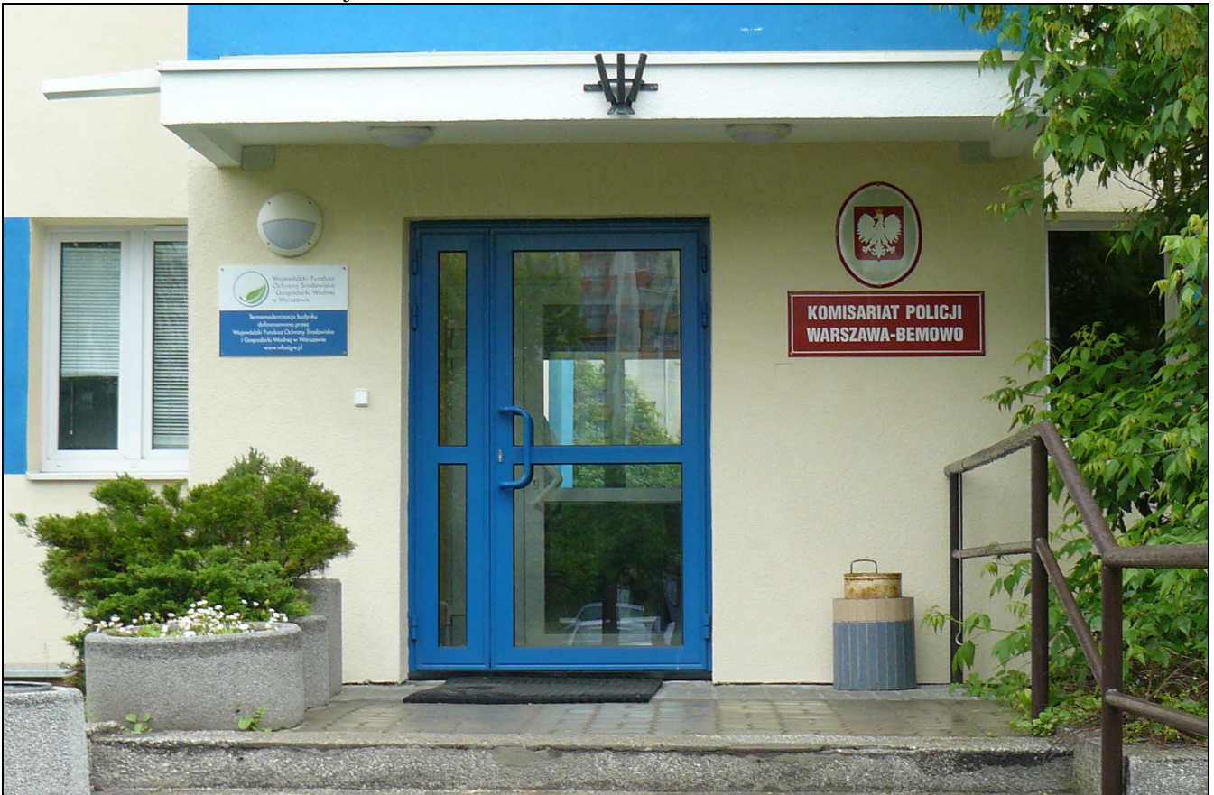
Fot. 18. Widok daszku na elewacji E-1
