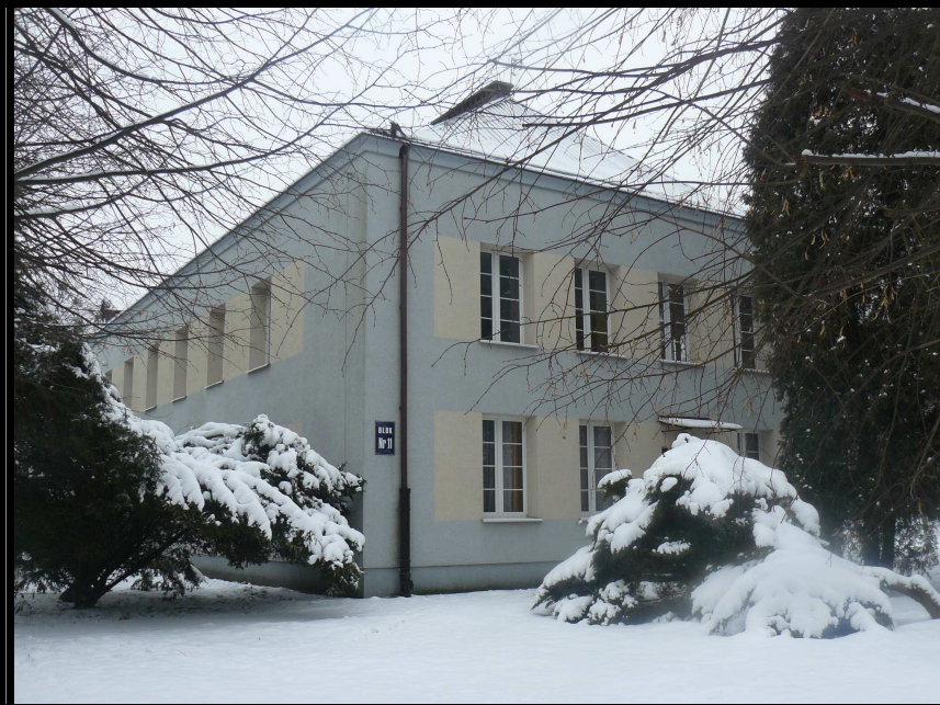
Elewacja boczna budynku koszarowego nr 11
