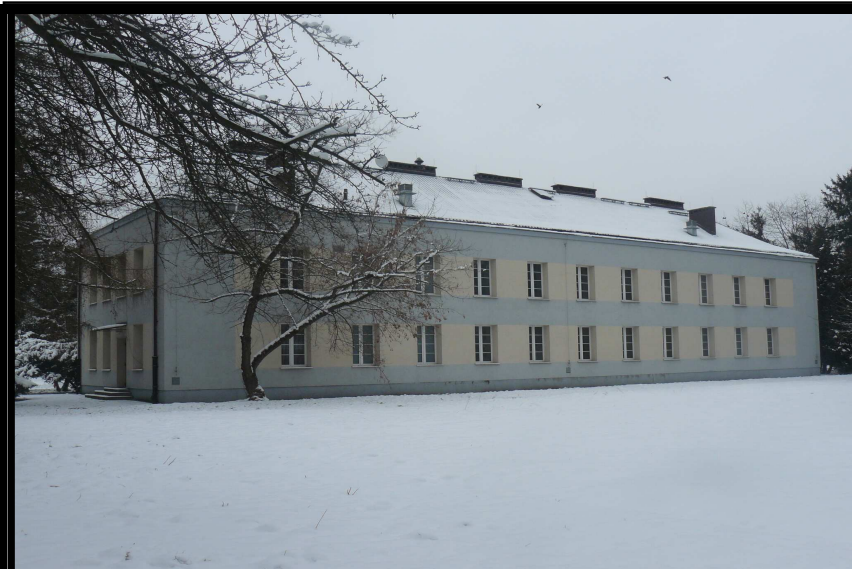
Elewacja tylna budynku koszarowego nr 11
