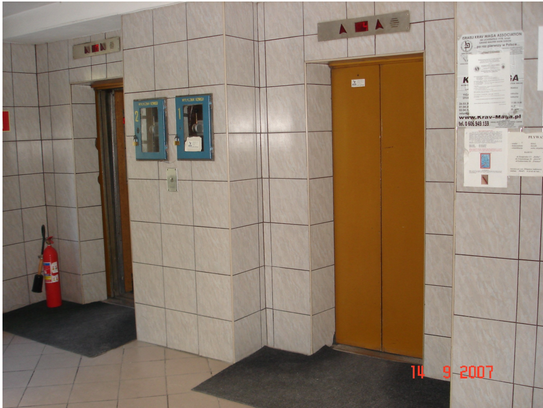
Parter dojście do wind
